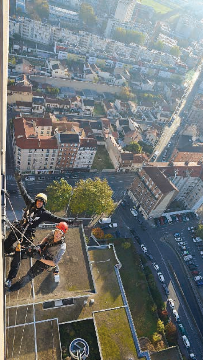
↑ Les alpinistes de la société Versant n'ont pas peur de s'aventurer à 120 mètres de hauteur pour entretenir la façade de la mairie.
